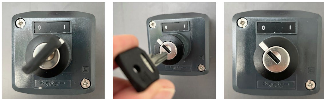
Abbildung 22: Abfolge Wiedereinschalten Schlüsselschalter
