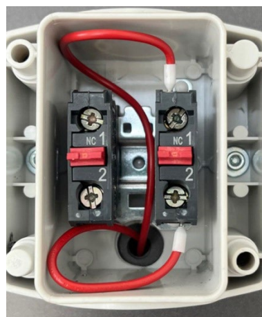
Abbildung 24: Kabelanschluss Notaus
